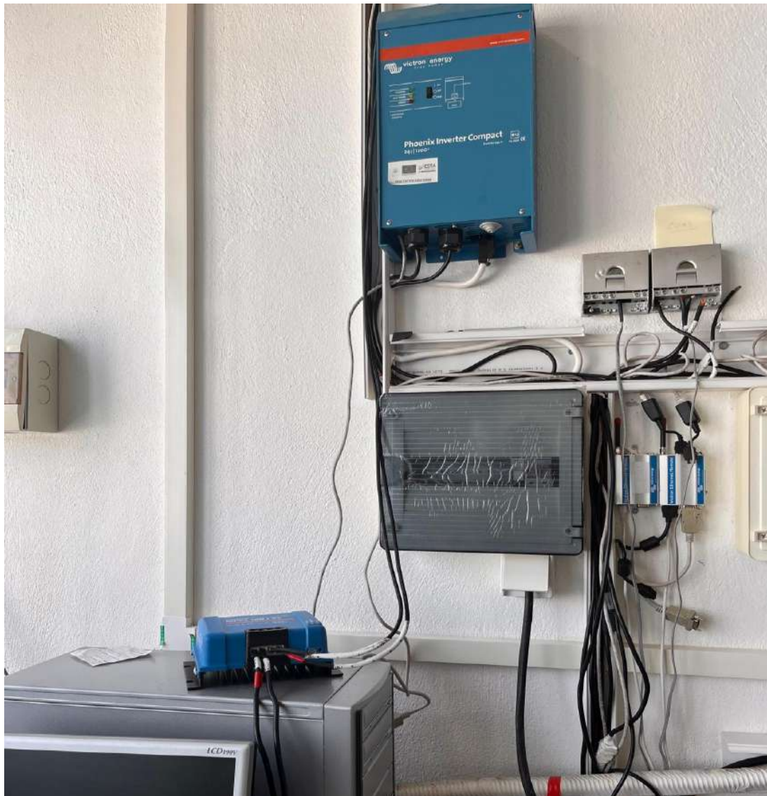
Σχ.33-2 Σύνδεση με το φωτοβολταϊκό στοιχείο.
